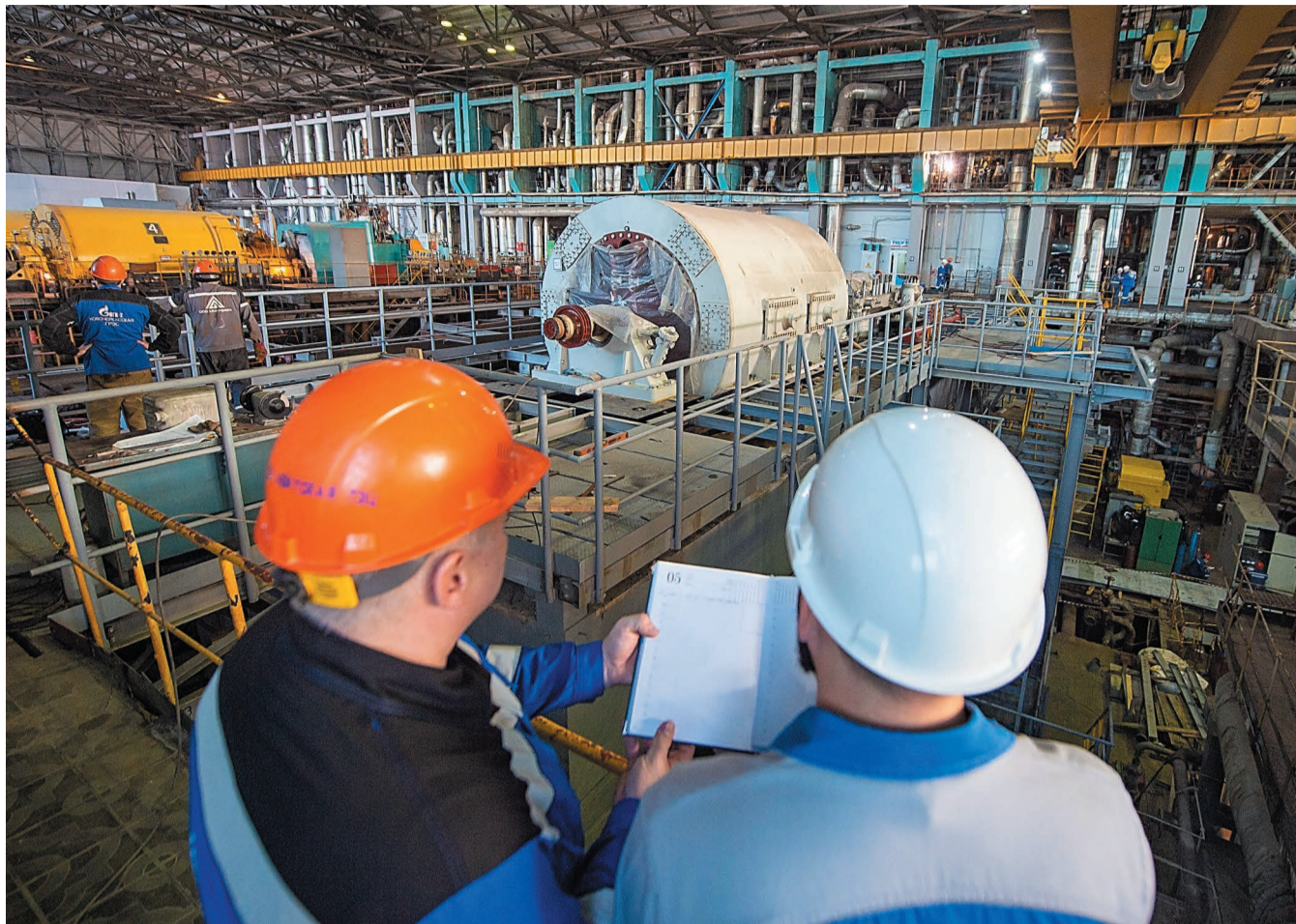
Ведется монтаж нового турбоагрегата ТГ-1
