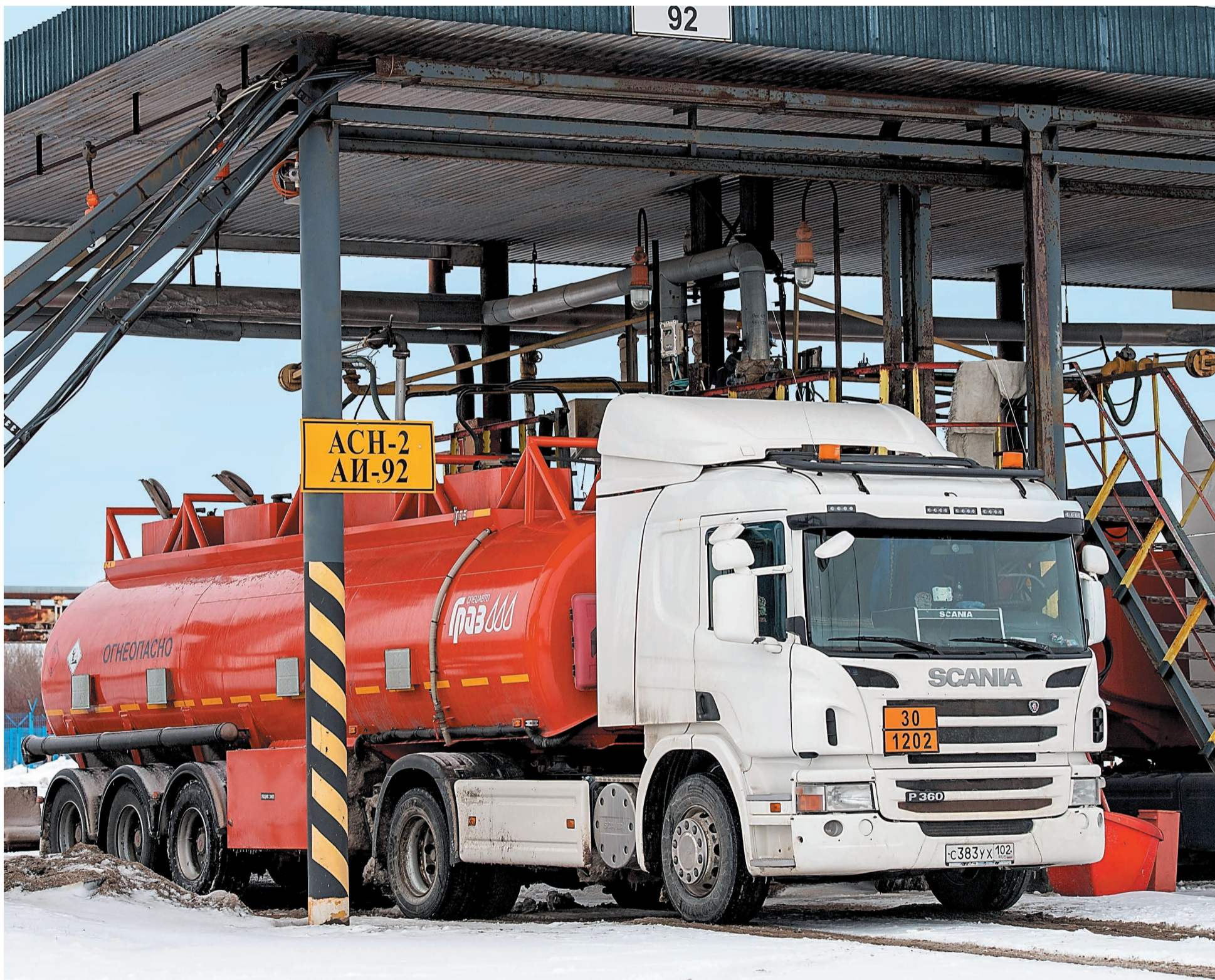
Установка налива автомобильных цистерн светлыми нефтепродуктами товарно-сырьевого цеха нефтеперерабатывающего завода
