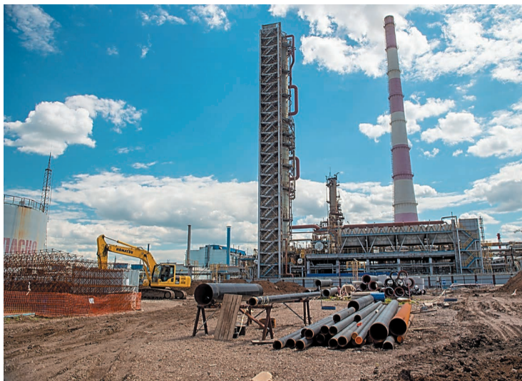
Идет реконструкция установки Л-35/11-1000
