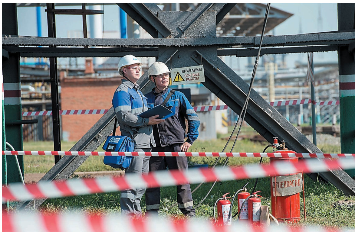
На промплощадке ежедневно проводятся работы повышенной опасности
