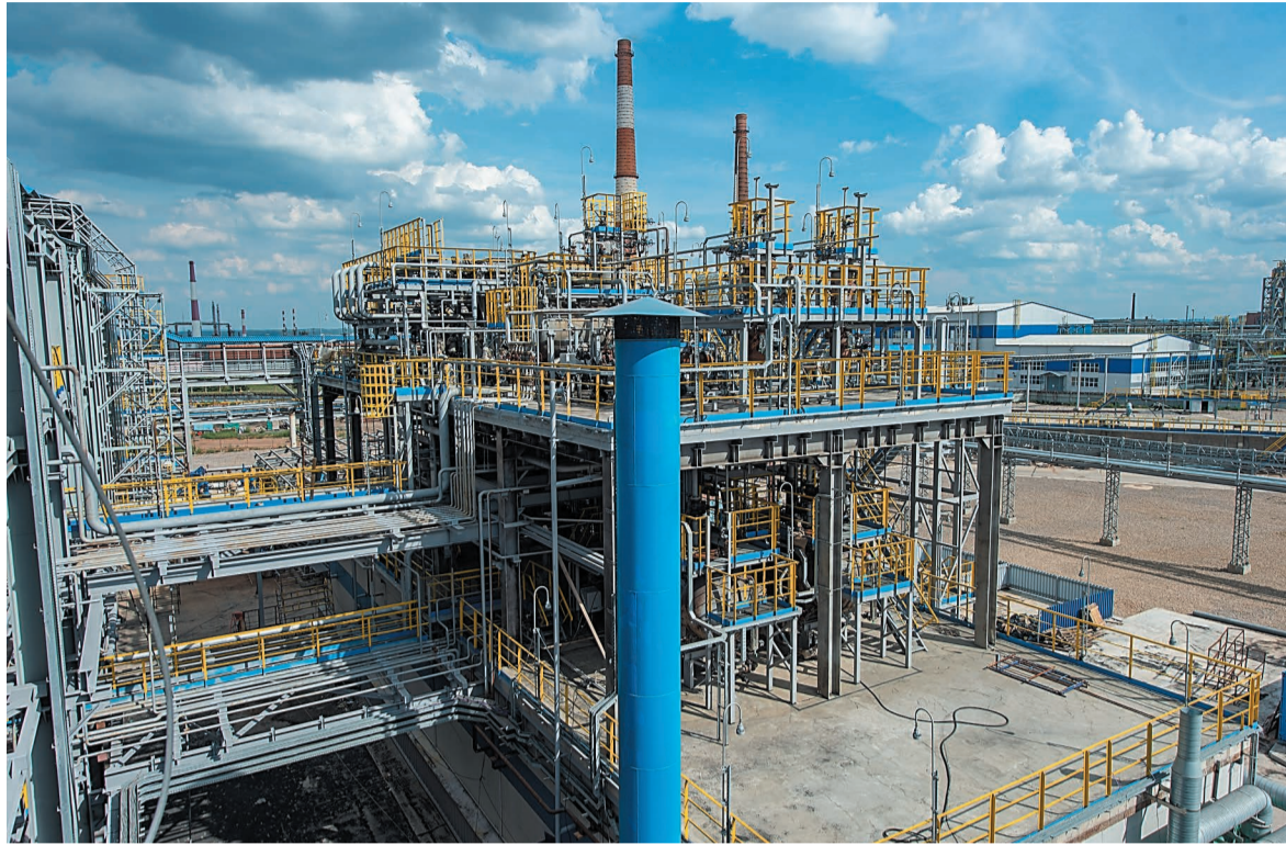
Строительство производства технической серы включено в Перечень приоритетных инвестиционных проектов Башкортостана
