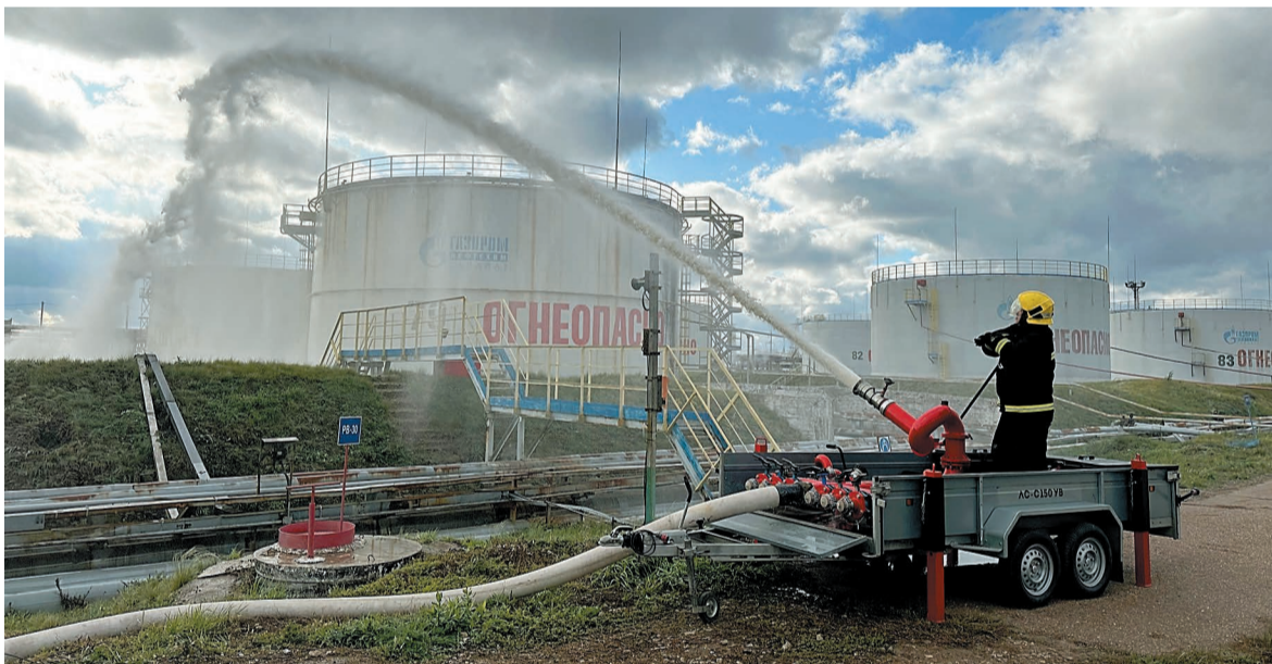
Проведенные работы позволят повысить пожарную безопасность резервуарного парка. Фото ПСЧ УЭПБиОТ
