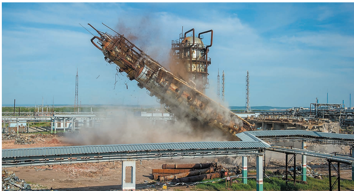
В 2015 году на нефтеперерабатывающем заводе демонтировали группу колонн установки АВТ-1 в связи с износом оборудования и вводом в эксплуатацию ЭЛОУ АВТ-6
