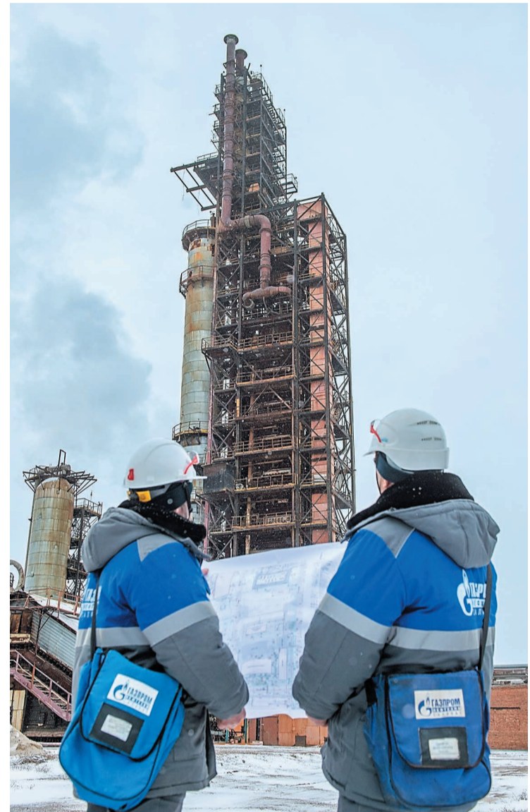
В 2024 году начнется работа по демонтажу установки каталитического крекинга КК-1, которая была введена в эксплуатацию в 1955 году
