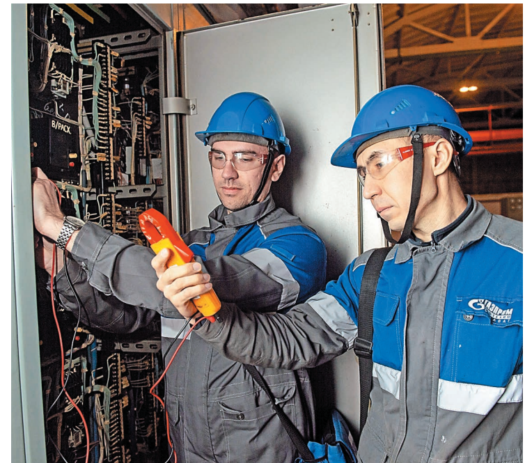
Электромонтеры участка № 3 Александр Когот и Ильдар Якупов
