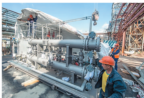
Идет строительство комплекса каткрекинга
