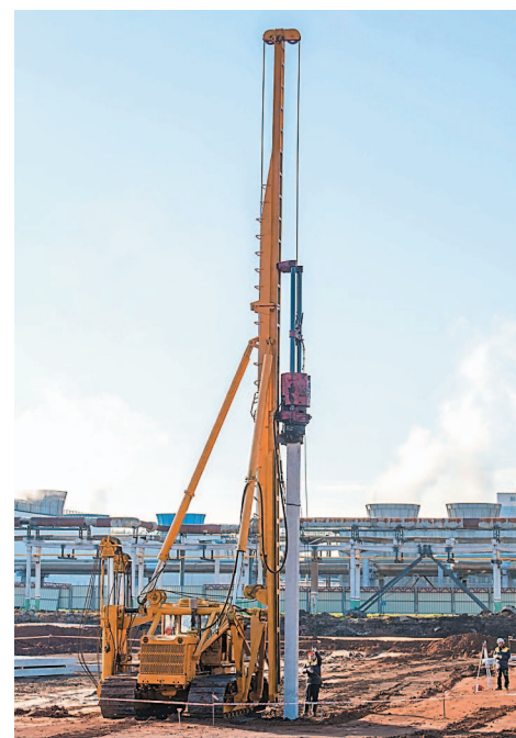
Первая свая на новом производстве технической серы
