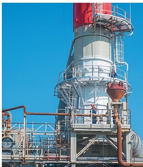
На строительстве производства водорода
