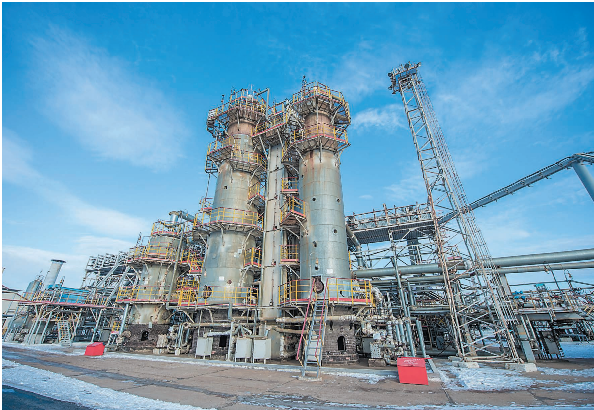
Установка производства битумов компании «Газпром нефтехим Салават»
