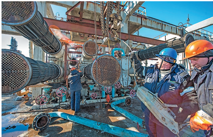
С внедрением проекта появится возможность рассчитывать показатели эффективности и отслеживать динамику изменений. На фото: разборка теплообменников во время капитального ремонта в цехе № 10
