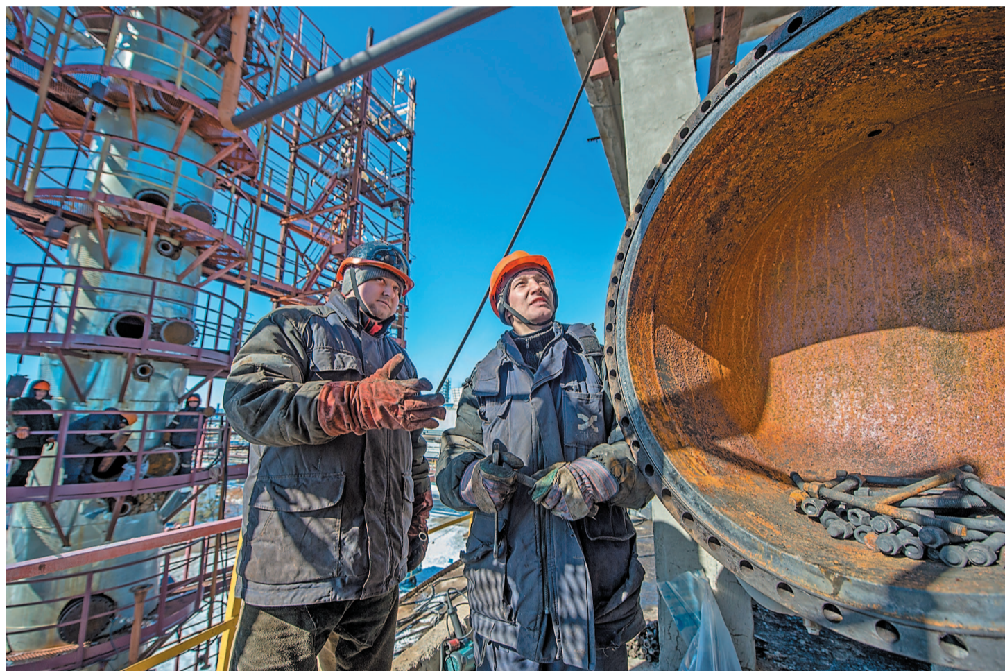
Проект ТОРО увеличит точность планирования ремонтных работ. На фото: ремонт водяных холодильников на газофракционирующей установке ГФУ-1
