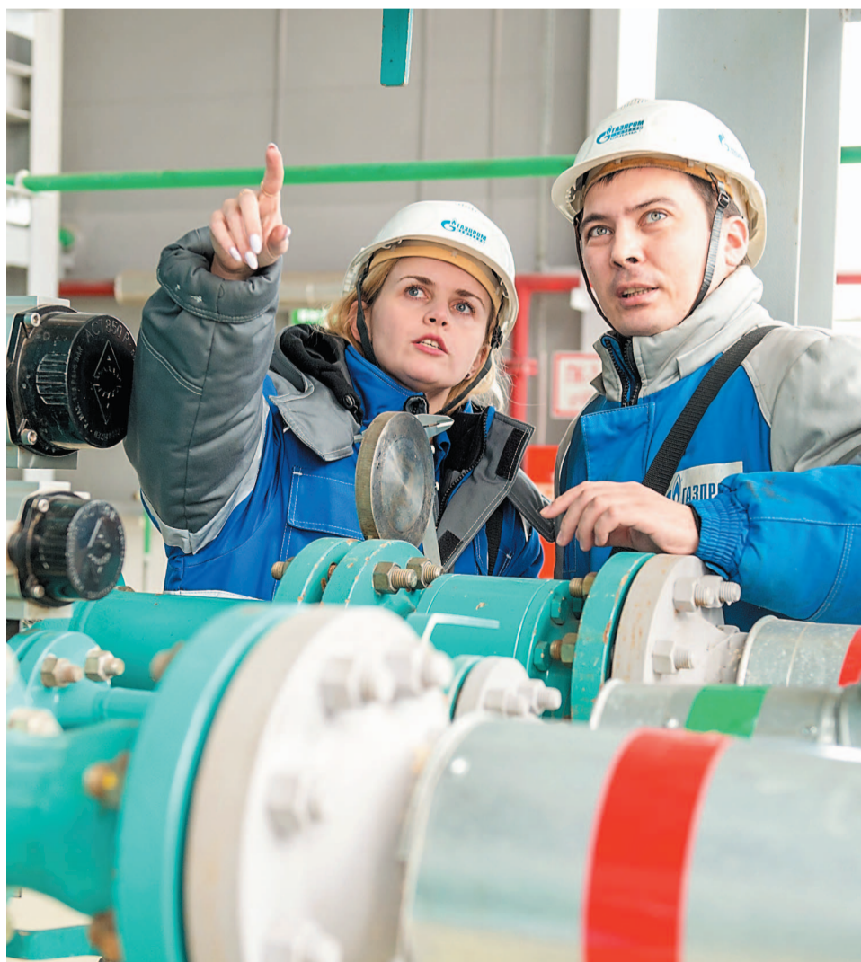
Инженер-конструктор механического сектора ПКО Ольга Ващенко производит замеры оборудования
