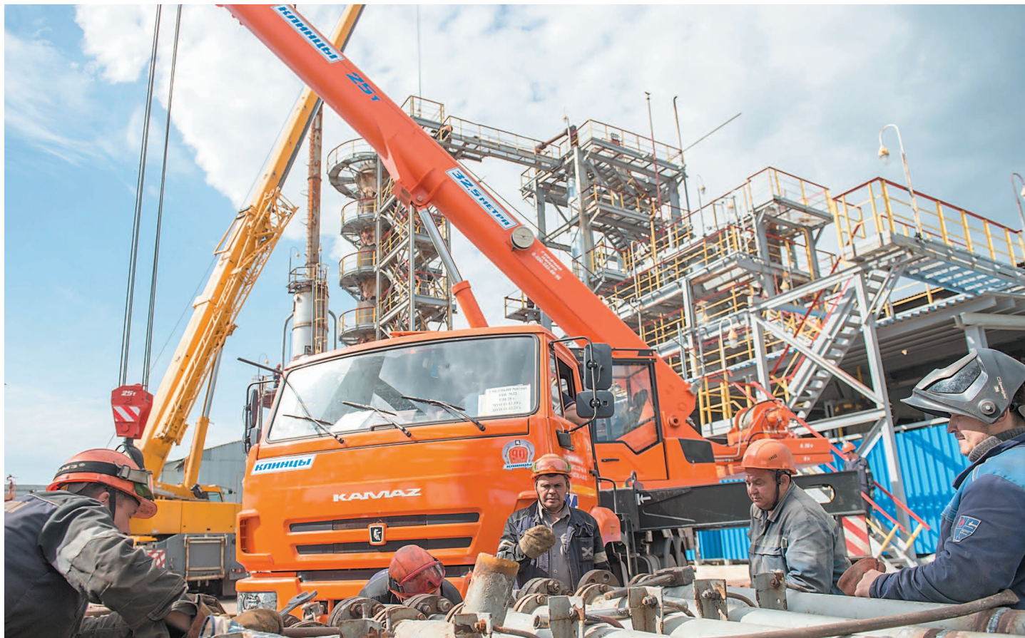
Ремонт теплообменника поз. Т-103 в цехе № 52
