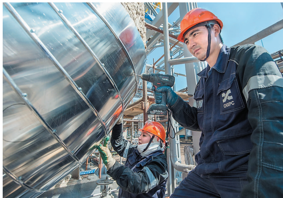
Монтаж теплоизоляции в цехе № 34 на новой емкости поз. Е-456
