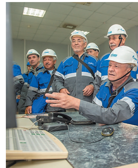
Установка гидроочистки дизельных топлив ЛЧ-4-6-2 введена в эксплуатацию в 1969 году. В результате поэтапной модернизации проектная мощность в 900 тыс. т в год доведена до 2028 тыс. т в год
