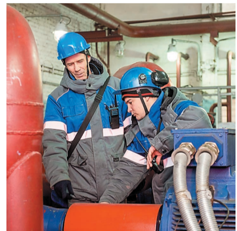
Машинисты Евгений Терехов и Егор Смеркалов осматривают оборудование
