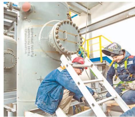
Производится монтаж площадок обслуживания на сепараторе С-16
