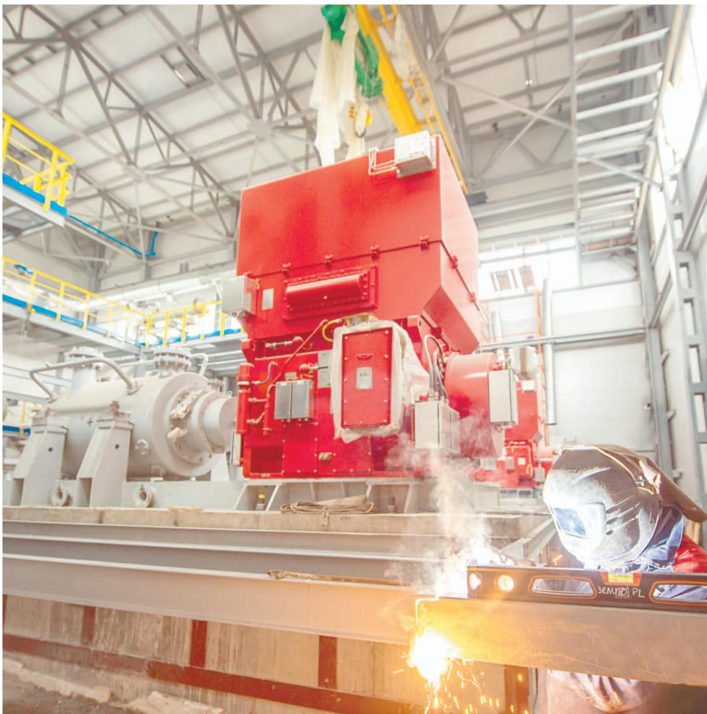
В рамках проведения 3-го этапа реконструкции установки гидроочистки – 2 цеха № 9 в настоящий момент производятся работы на реакторном блоке. Здесь установлены два новых центробежных компрессора, которые в будущем заменят три старых поршневых компрессора. После реализации данного проекта производственники смогут выйти на более высокие проектные показатели.
