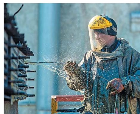
Промывка трубок воздушного холодильника поз. ВХ-12 на установке КК-2
