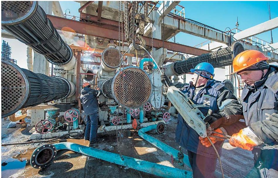
Демонтаж трубного пучка теплообменника поз. А-22/2 на установке ГФУ-1
