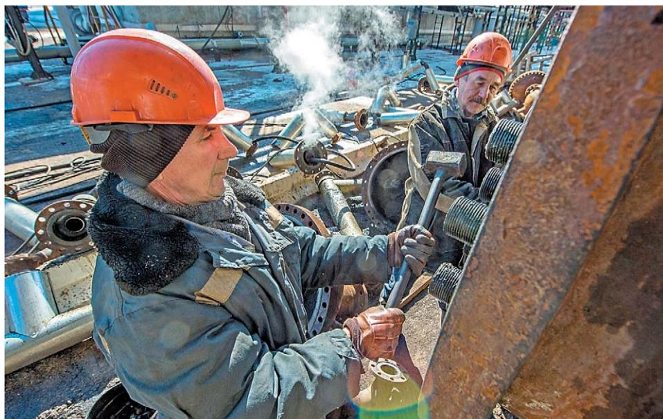
Выбивание трубок трубного пучка на теплообменнике поз. Т-3/2 на установке КК-2
