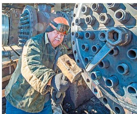
Разбалчивание крепежа трубки трубного пучка теплообменника поз. Т-3/3 на установке КК-2
