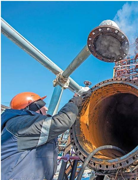
Ремонт ребойлера поз. А-24 на установке ГФУ-1
