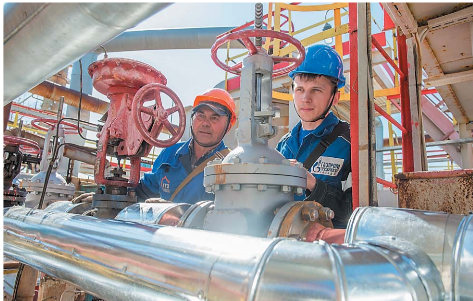
На сепараторе поз. С-2К проведены работы по увеличению диаметра выходного штуцера и замене участка трубы для подачи факельных газов в топливную сеть Общества
