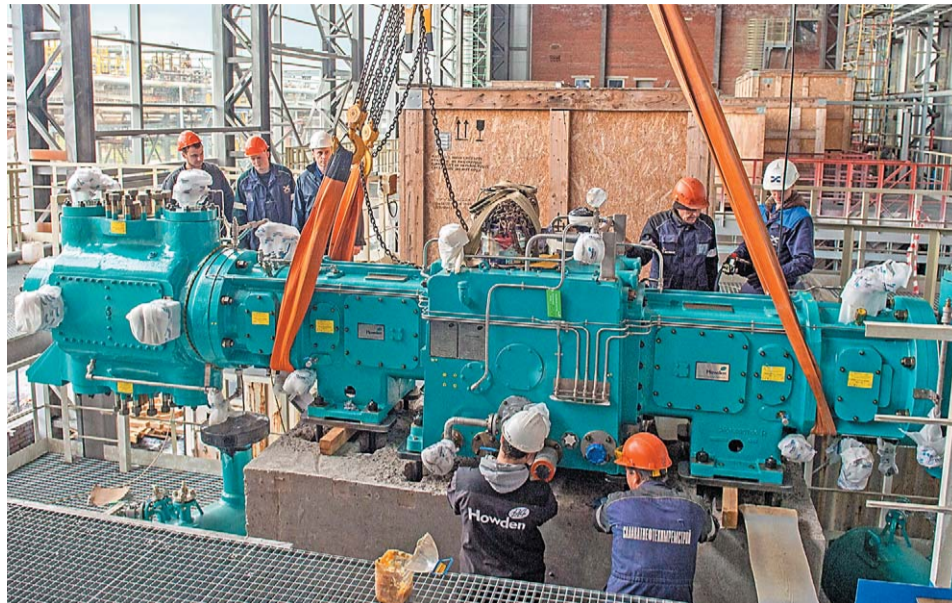
Монтаж компрессоров ведут специалисты «СНХРС» совместно с представителями компании-поставщика компрессорного оборудования Howden
