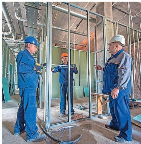
В бактериологической лаборатории СЦС монтируются межкомнатные перегородки
