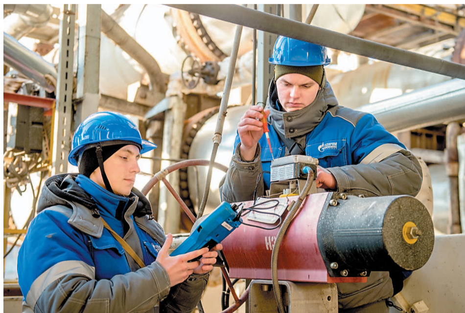
Сегодня цех автоматизации НПЗ насчитывает 8 участков по обслуживанию средств КИП и участок пусконаладочных работ на установке ЭЛОУ АВТ-6
