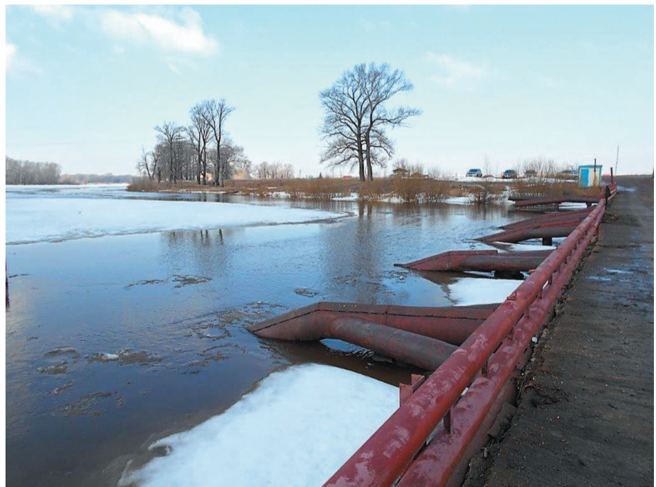
Мост в районе ДЮЦ «Спутник» – ответственный участок в дни весеннего половодья
