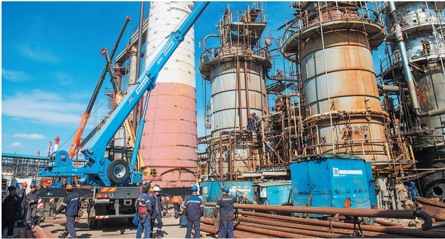
Монтаж трубопровода на линии дизтоплива и водородосодержащего газа в цехе № 9
