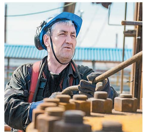
Монтажник центрует участок трубопровода на установке ГО-3
