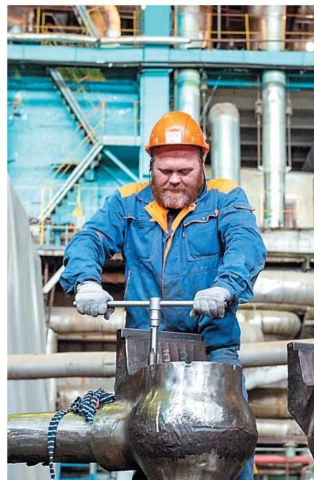
Разборку оборудования на турбогенераторе ТГ-5 ведет ООО «БалтЭнергоМонтаж»
