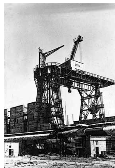
200 тонный козловой кран
