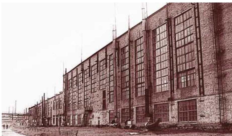
Корпус насосной высокого давления цеха №21
