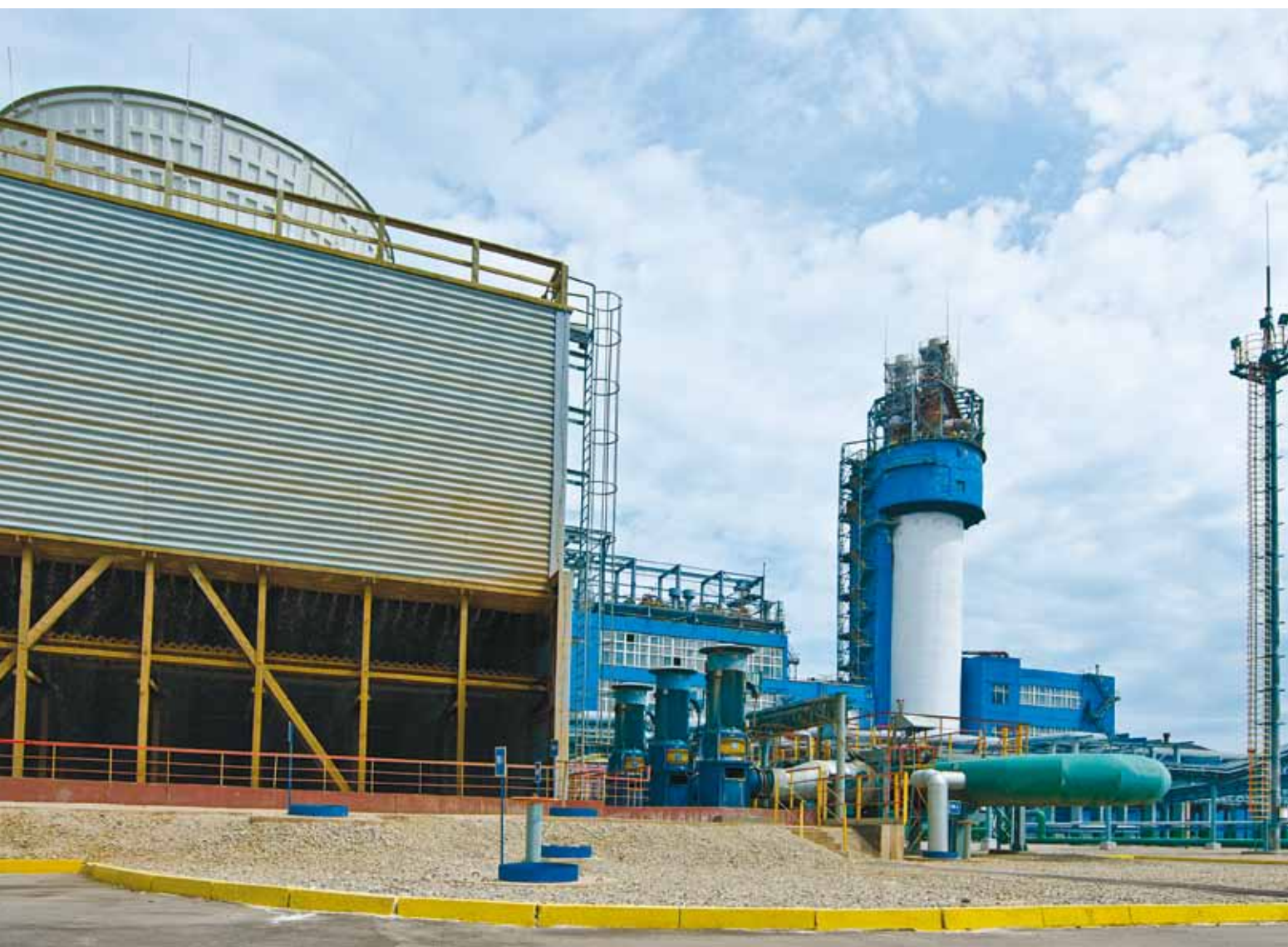
Установки завода карбамида
