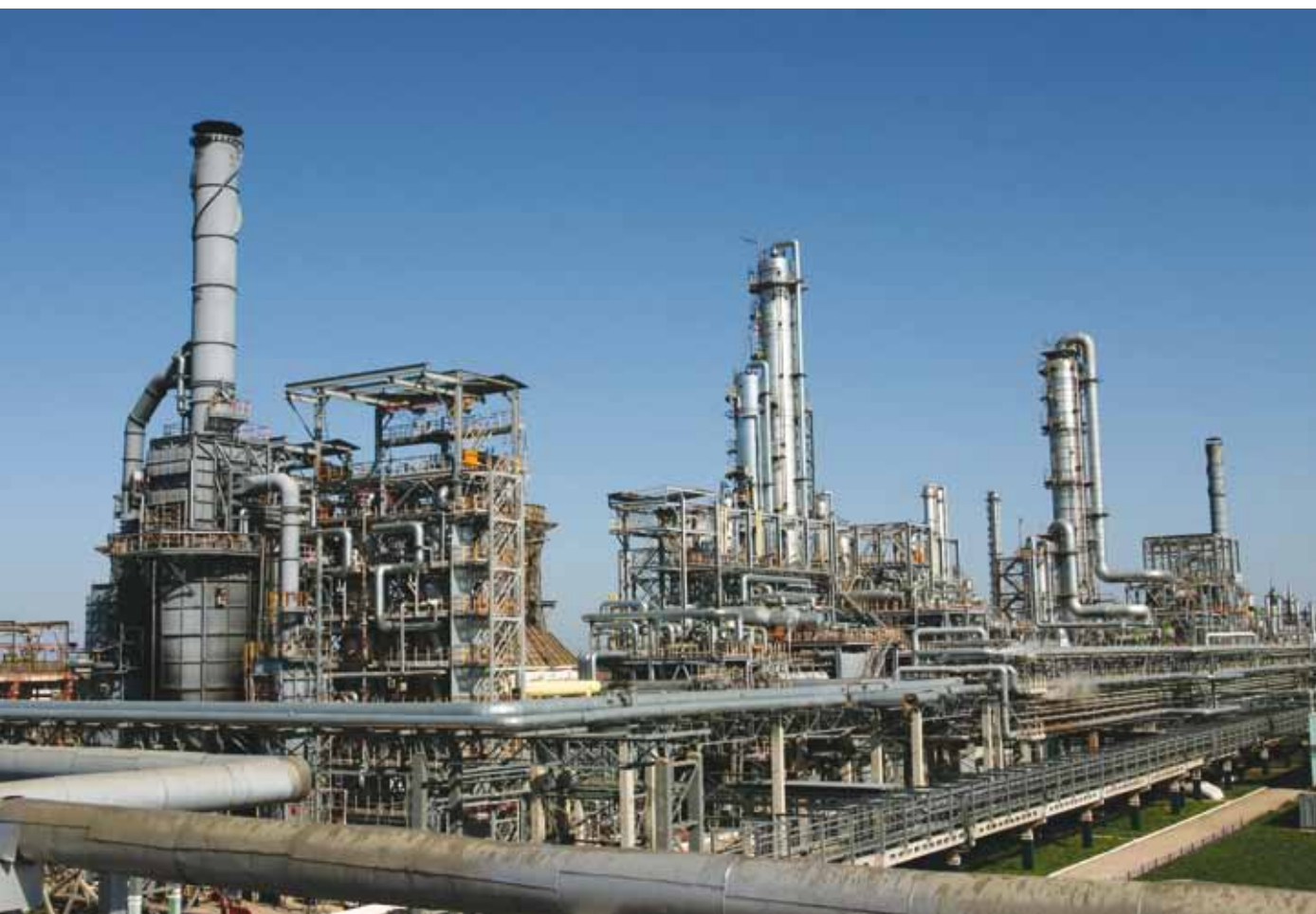
Установка цеха этилбензол стирола
