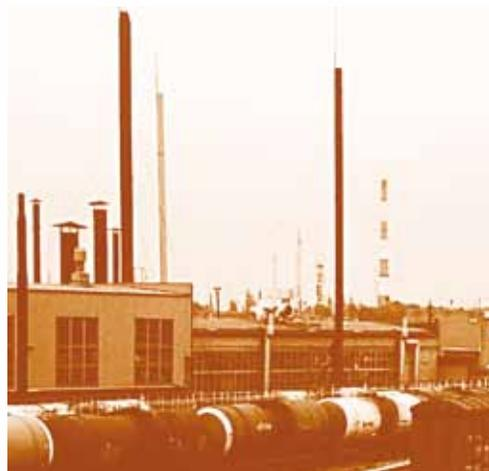
31-й путь. Метр за метром отвоевывая у оврага площадь, постепенно подсыпали насыпь и рядами прокладывали рельсы. Там имелась водопропускная труба, так ее пришлось удлинять несколько раз, прокладывая через нее очередной путь. Стесненное условие прокладки под трубопроводной эстакадой привело к кривизне путей станции в плане.
