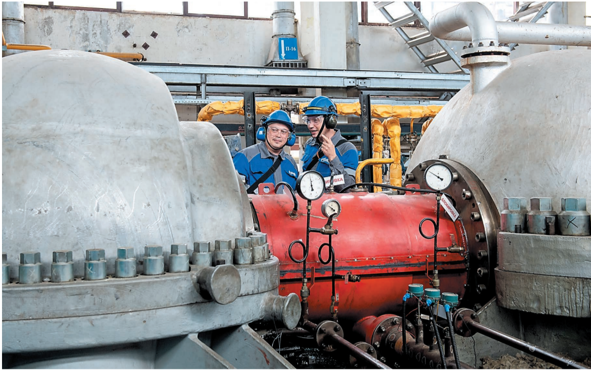
На производстве ЭП-355
