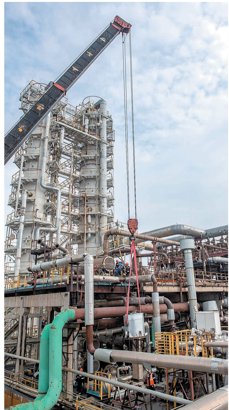
Во время капитального ремонта 2024 года
