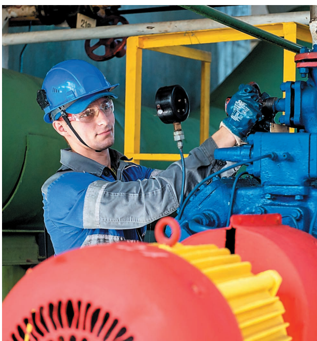
После ремонта установки цеха № 20 выведены на нормальный технологический режим
