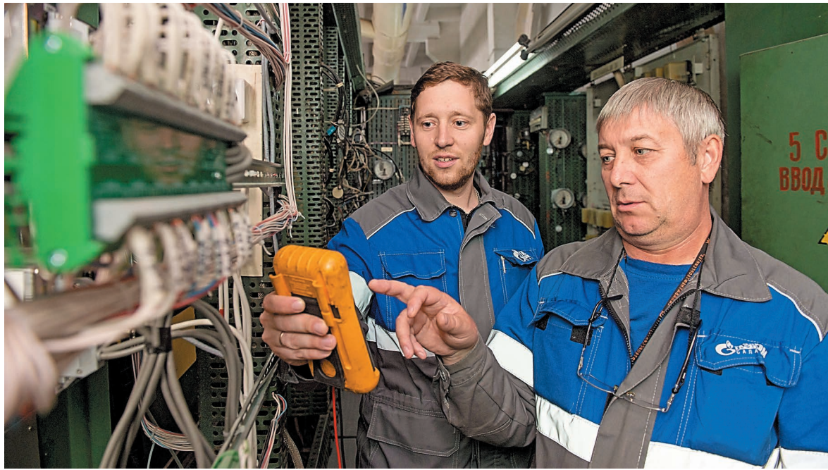
В общей сложности более 150 позиций хозрасчетных параметров было оснащено новым современным оборудованием
