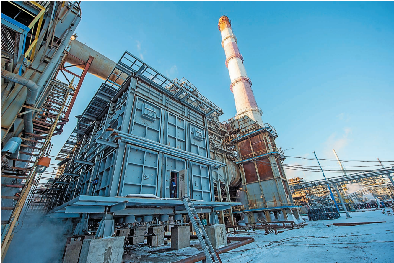
Строящаяся печь позиции П-2 реакторного блока
