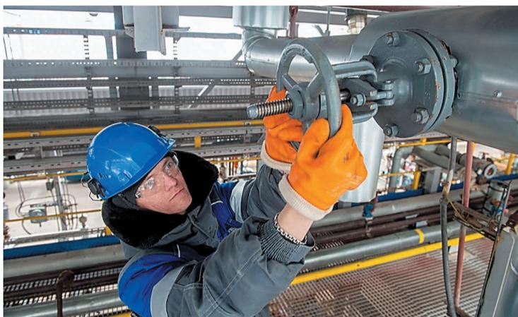
*Производится перенаправление потока тяжелого изомеризата*
