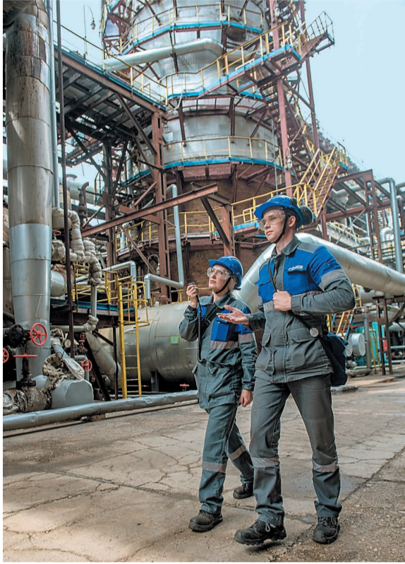
Установка подготовки пирогаза
