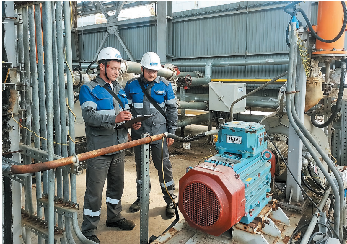
В открытой насосной установке ФОС завершается установка арматуры после ревизии
