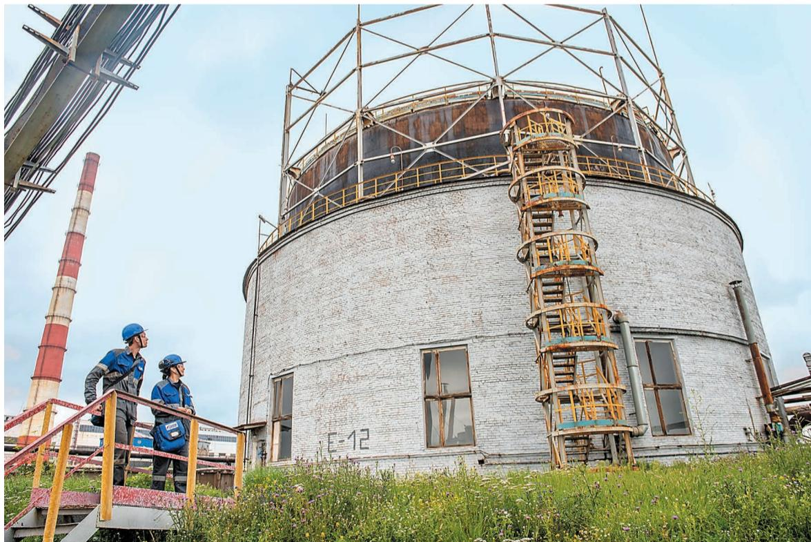
Газгольдер обеспечивает гарантированный запас факельных газов для работы компрессоров
