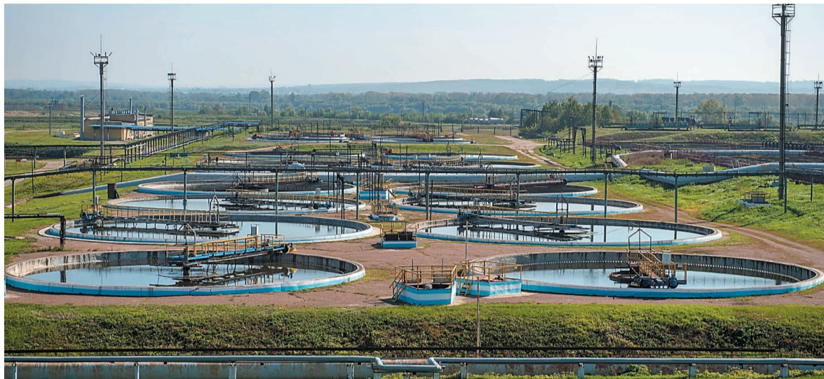
Цех биохимической очистки, вторичные отстойники
