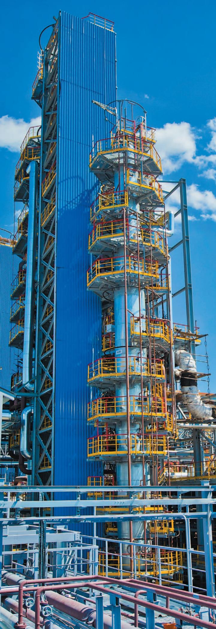
получения нефти нестабильной, газойля, газойля вакуумного, мазута, кислых газа и воды. В составе: воздушная компрессорная (для снабжения осушенным воздухом давлением до 0,8 МПа, проектная мощность – 12 тыс. нм<sup>3</sup>/ч), насосная пожаротушения (для локализации аварийных ситуаций, расход воды – 220 л/с.), комплектная трансформаторная подстанция и распределительное устройство (для распределения эл. энергии потребителям с напряжением 6 кВ и 0,4 кВ, суммарной мощностью 5400 кВт).
