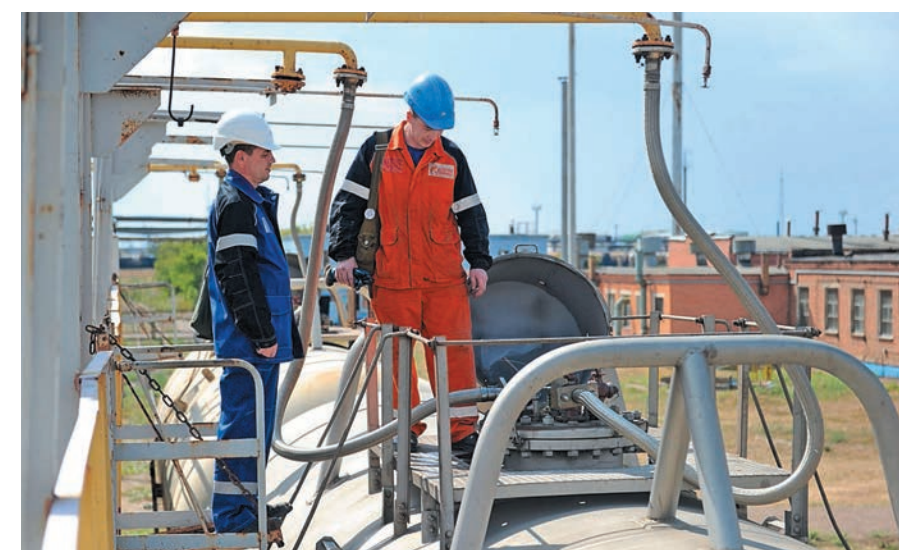
Сливо-наливная эстакада УЖГ. Товарный оператор В.П. Колесников и сливщик-разливщик И.В. Подвальный
