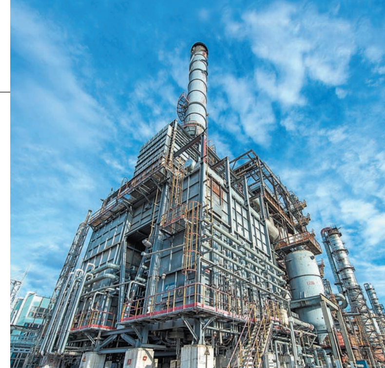
Установка стирола, отделение дегидрирования
