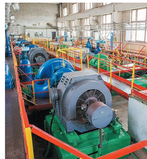
Машинный зал установки водооборотного снабжения производства
