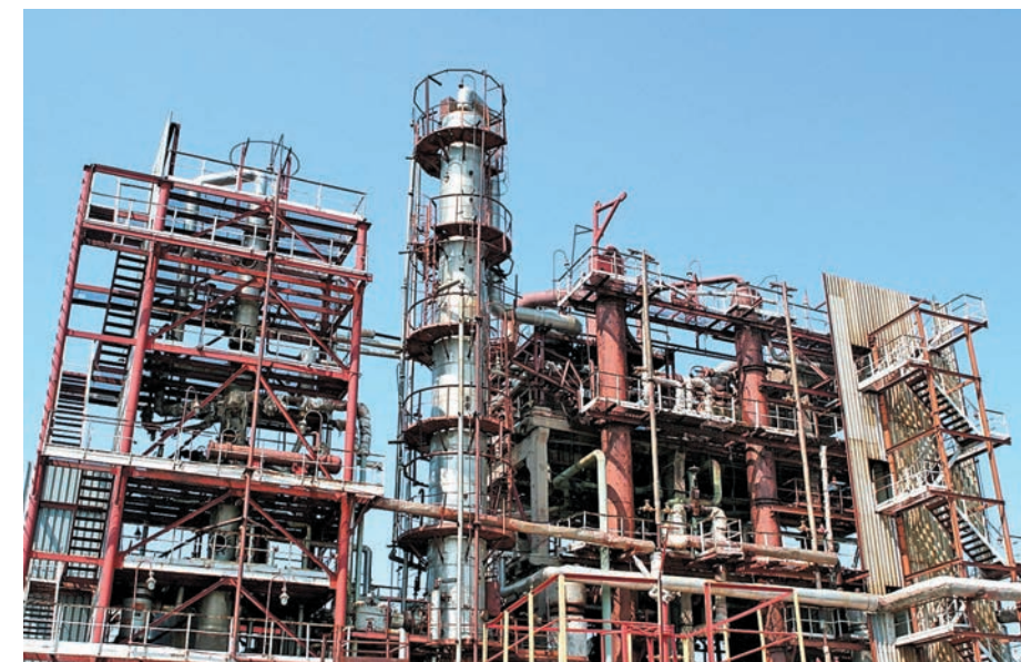
Этажерка установки конденсации масляного альдегида
