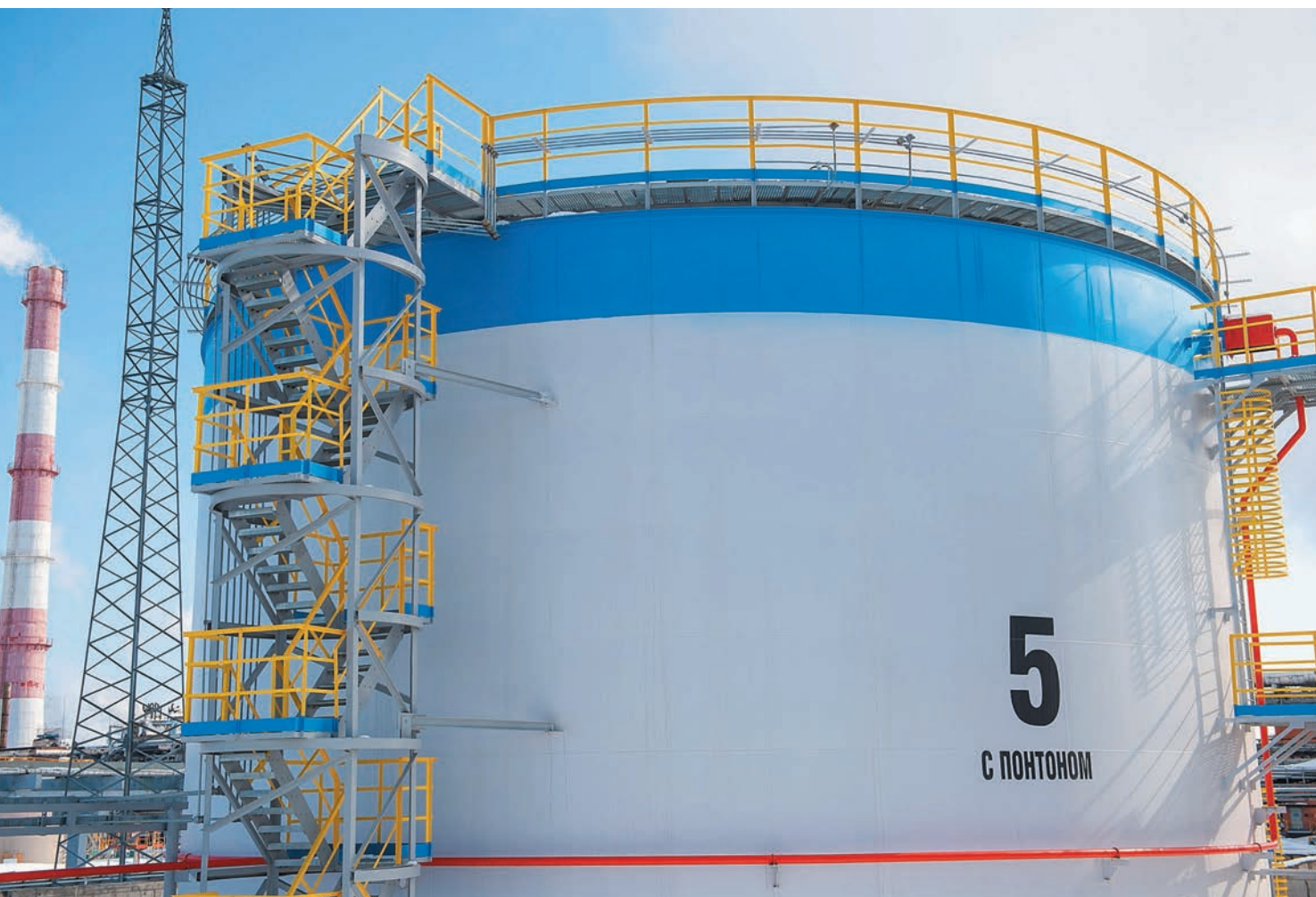
Резервуар для хранения бензина поз. Р-5 установки УПС
