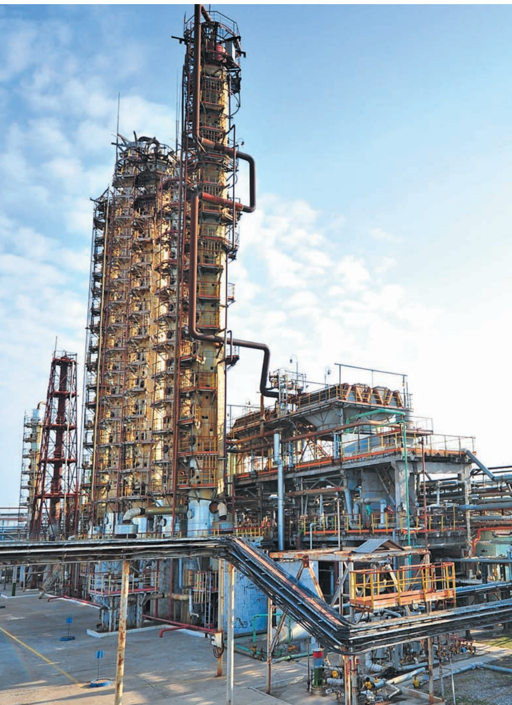
Установка ректификации – последняя стадия производства 2-этилгексанола
