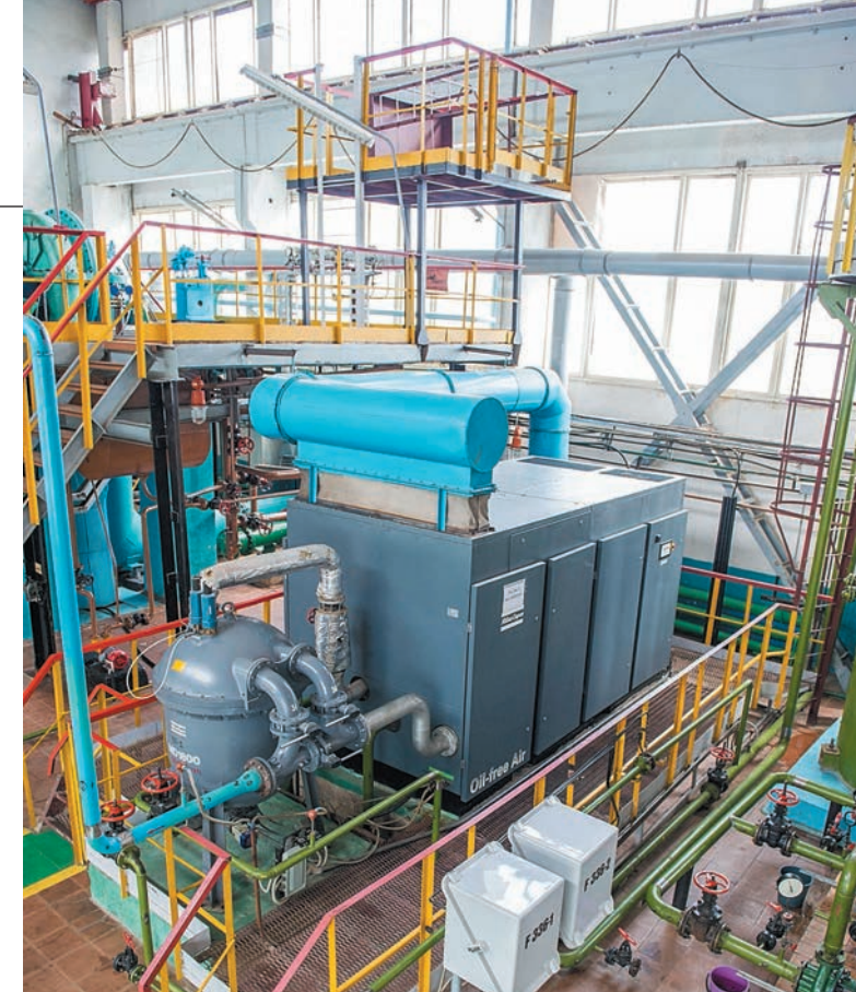
Воздушный компрессор Atlas Copco подает воздух для создания вакуума в системе термообработки и дистилляции фталевого ангидрида
