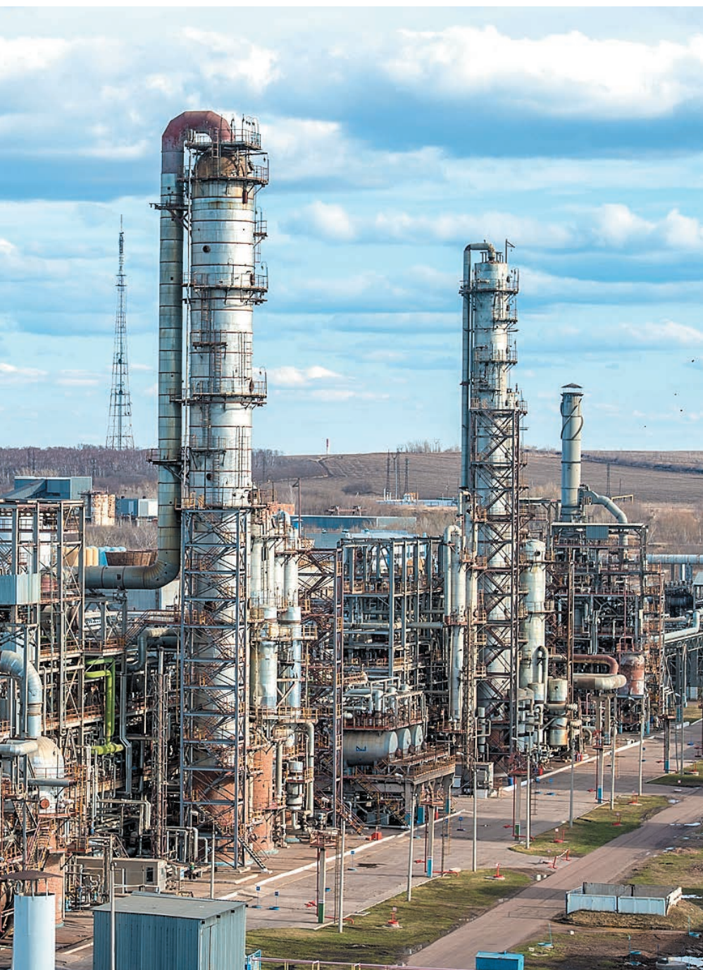
Слева направо: установка стирола и установка этилбензола
