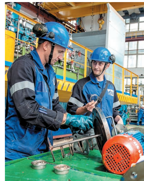
Ревизия арматуры узла подачи конденсата пара на уплотнения компрессора поз. М-213
