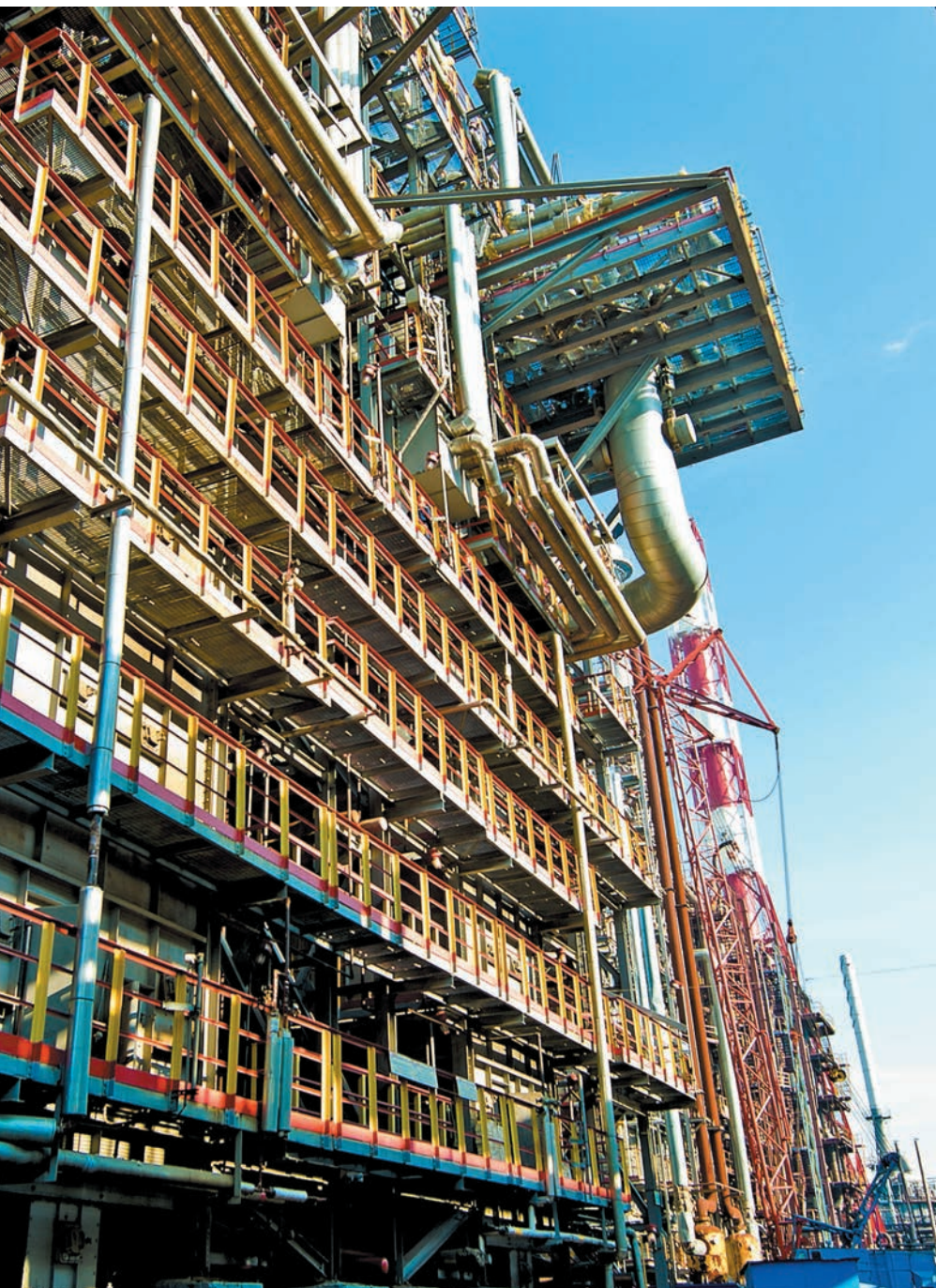
Печи пиролиза нового поколения типа SRT-VI
