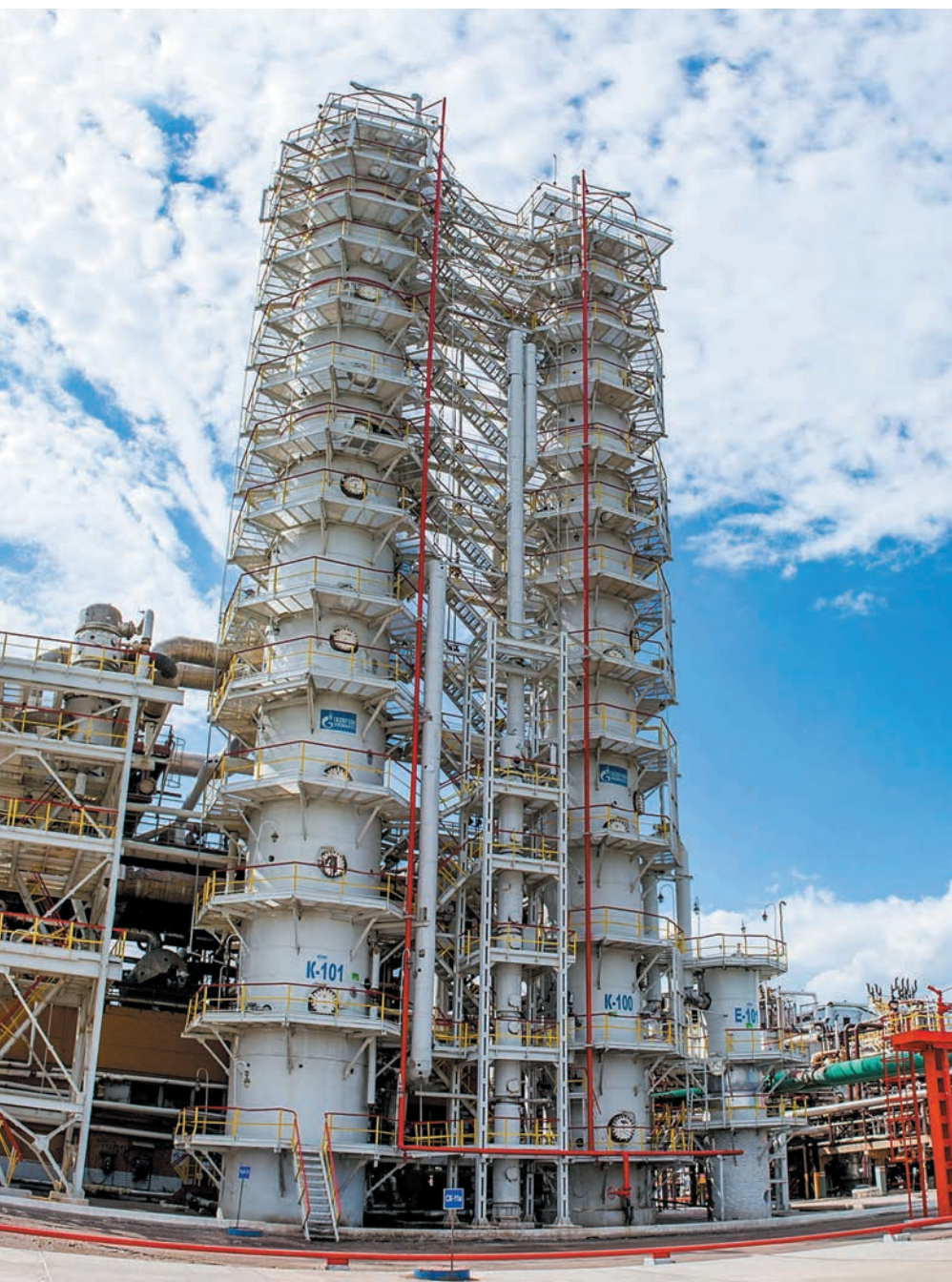
Колонны абсорбции и десорбции предназначены для очистки конвертированного газа от двуокиси углерода
