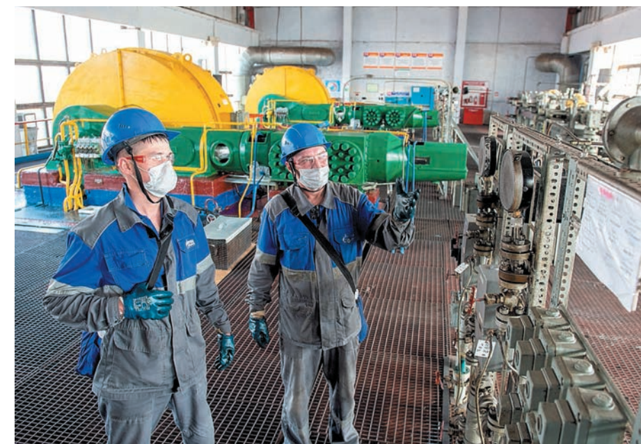
Машзал установки компрессорной и насосной высокого давления
