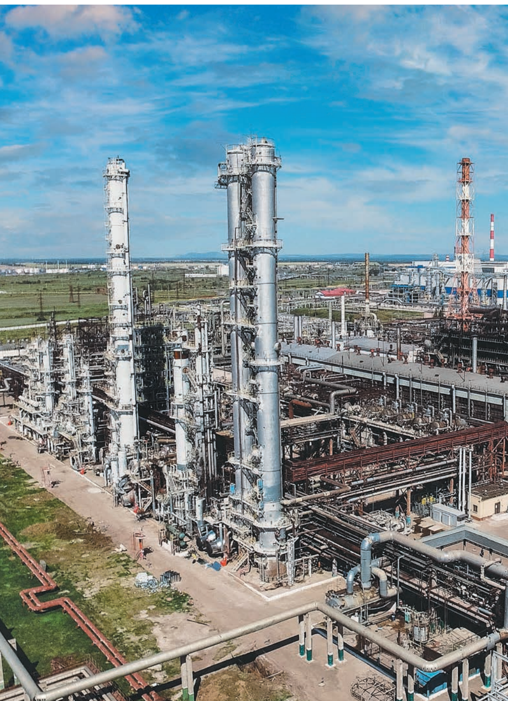
Блок колонн цеха газоразделения
