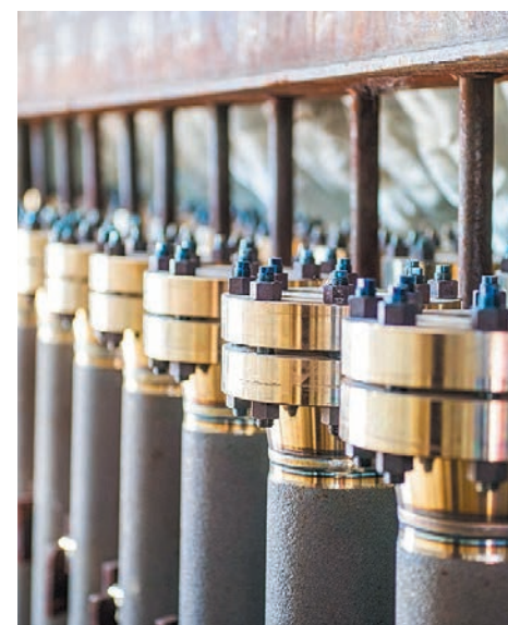
Реакционные трубы печей конверсии производства фирмы Kubota. Смонтированы на печи поз. П-101/2 в 2015 году
