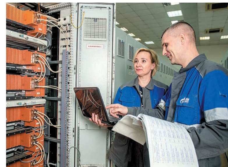
Диагностика контроллера Yokogawa ProSafe. Инженер по АСУ ТП И.В. Герасимова и ведущий инженер по АСУ ТП Е.Н. Топчий
