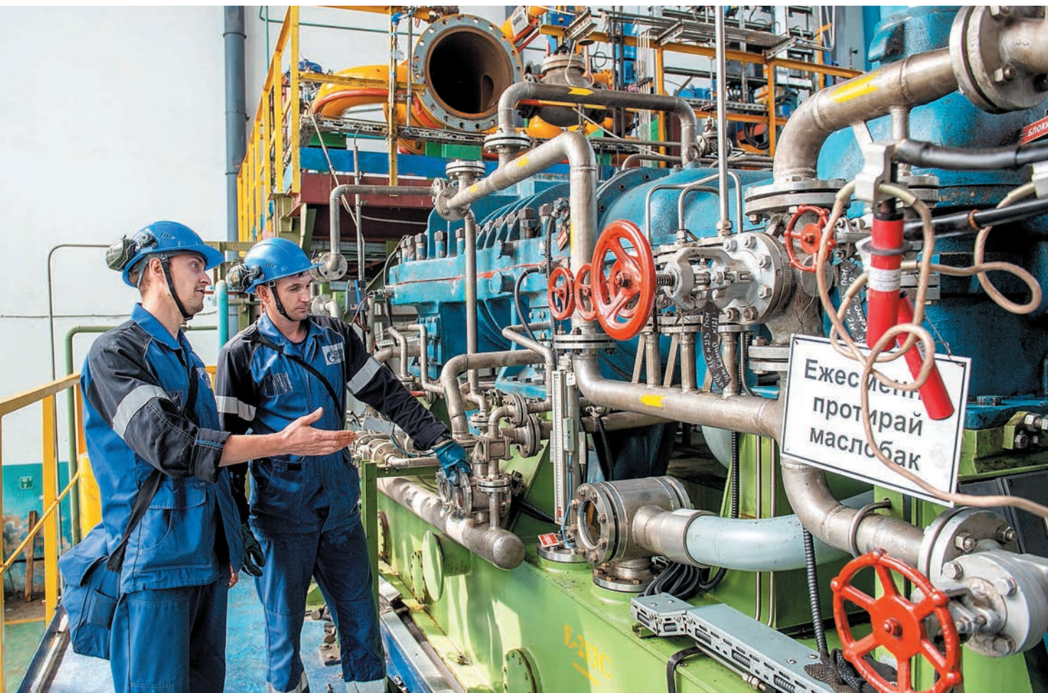
Проводится осмотр трубопроводов и арматуры циркуляционной системы смазки компрессора поз. М-213 в период капитального ремонта цеха № 46
