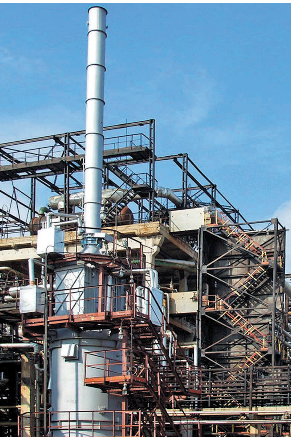
Печь поз. П-303 для нагрева смеси бензол-толуольной фракции и ВСГ
