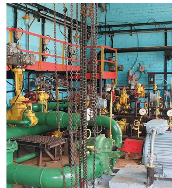
Насосная пенотушения объектов цеха № 34 и ТВ-1 ТСП «Мономер»
