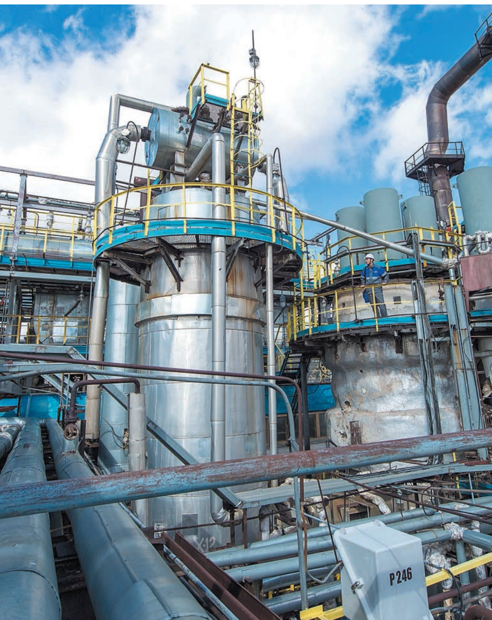
Реакторный блок окисления ортоксилола кислородом воздуха производства фталевого ангидрида
