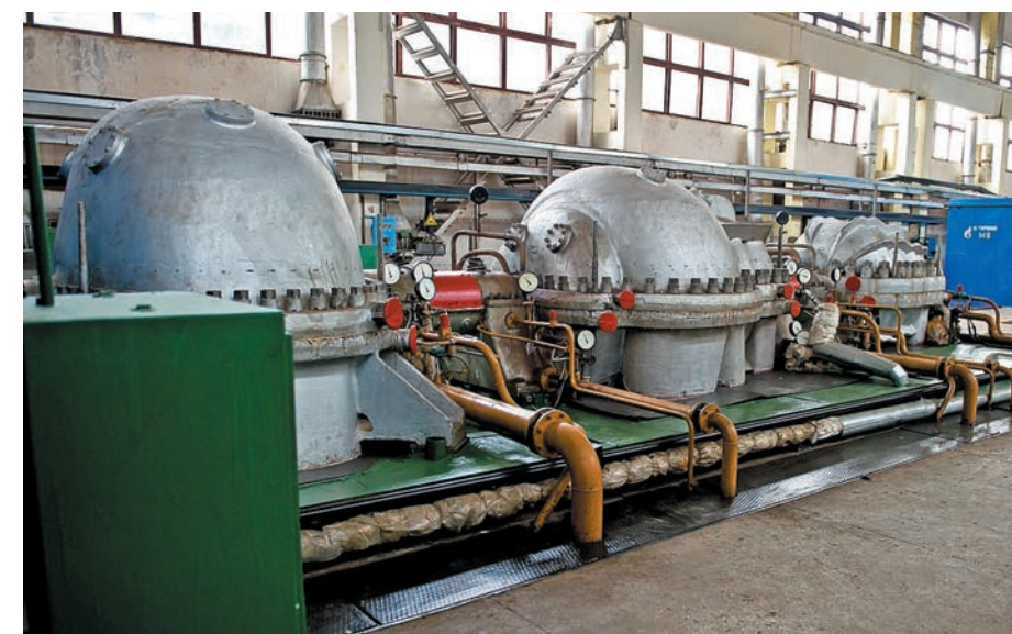
Компрессор поз. М-1 цеха № 56 до замены. После замены компрессора поз. М-1 цеха № 56 в 2012 году была повышена производительность производства ЭП-300 до ЭП-380
