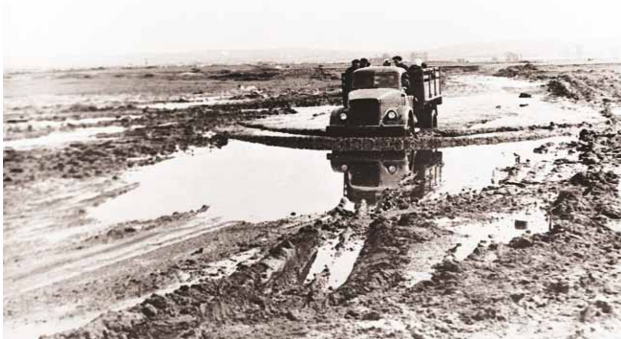
Дорога на месте будущей улицы Ленина
