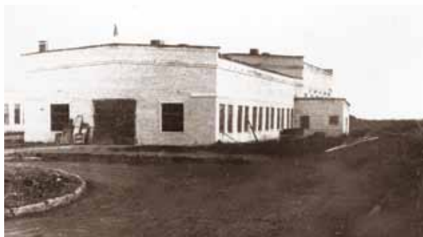
Здание капитального ремонта автомобилей
