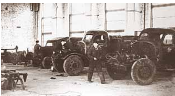
В ремонтном боксе
