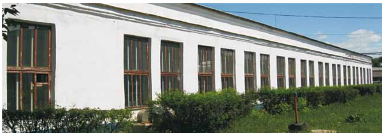
Здание ремонтного цеха
