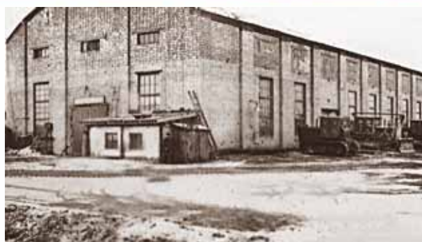
Ремонтный бокс КТГ
